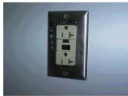
廚房、浴室水汽多，插座應裝置漏電遮斷器。以避免電器用品漏電、造成使用人感電。
