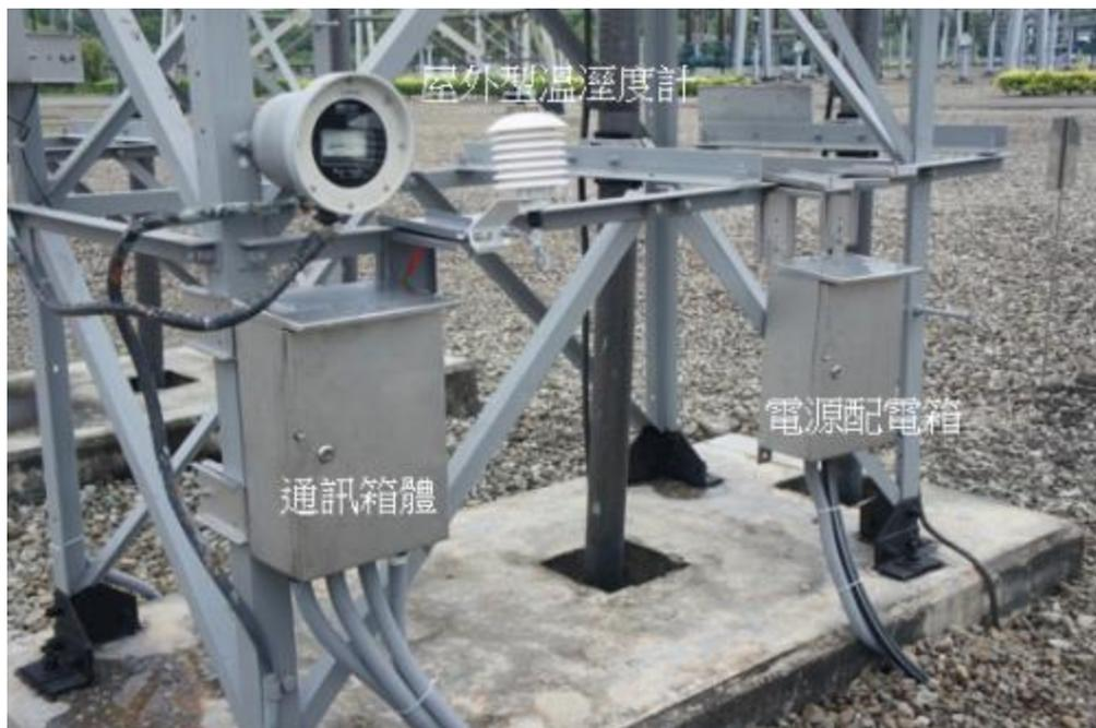
圖 7.20 屋外型溫溼度計設置位置圖
