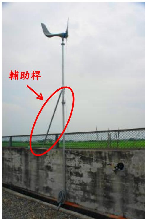
圖 7.8 現地風力發電機架設圖
