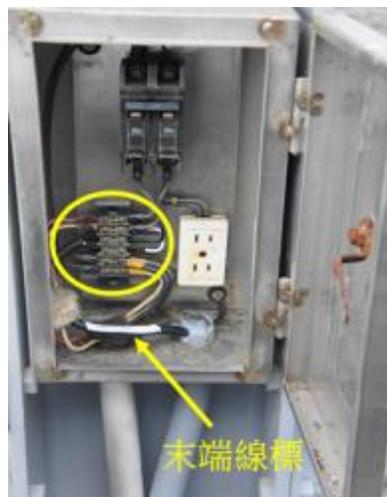
圖 7.14 電源引接圖(使用備用端子)
