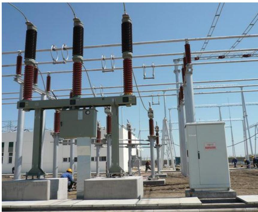
圖 5.2 陳甫 220 kV 變電所之戶外斷路器與智慧控制單元圖
