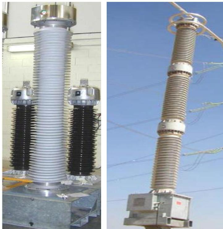
圖 2.16 分壓原理之電壓互感器案例圖(戶外型)
