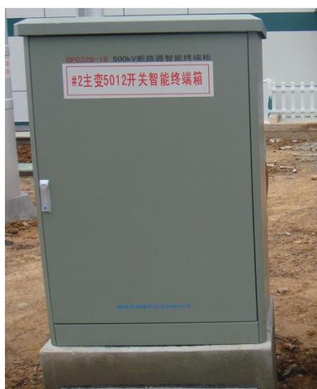
圖 5.4 蘭溪 500 kV 變電所之戶外智慧型終端機圖
