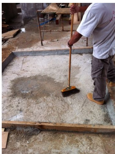
2.4 將混凝土表面沙石粒先行清理
