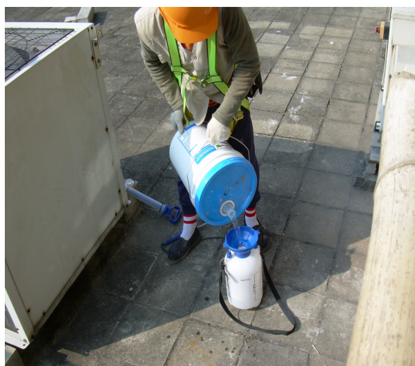
2.5 將 DPS 倒進一般低壓手提噴壺
