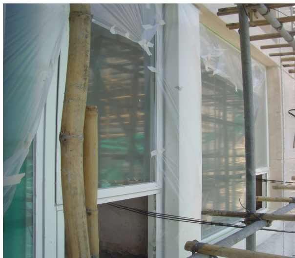
2.2 將鄰近鋁制品、玻璃面用膠紙作保護
