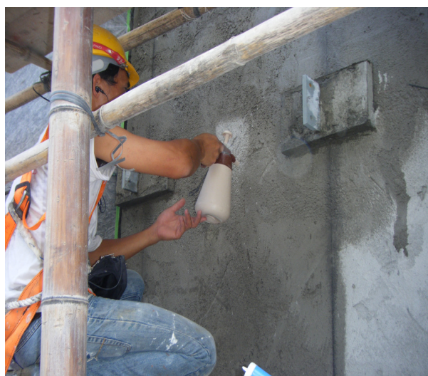
2.5 將 DPS 倒進一般低壓手提噴壺
