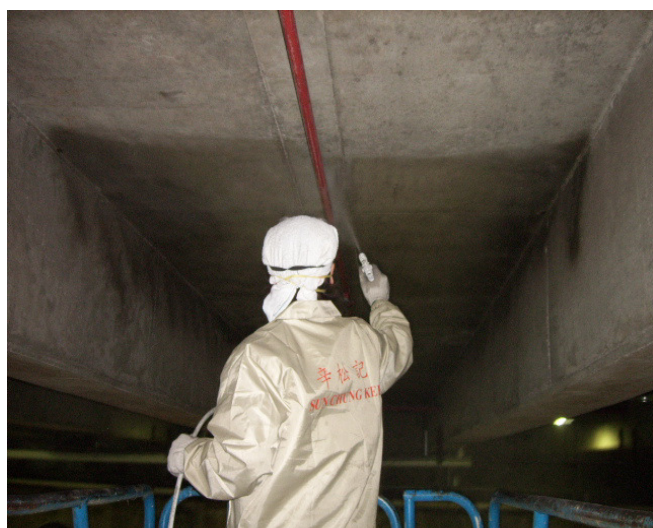
2.6 充份噴在混凝土表面，維持 5 秒濕面便可； 相隔 24 小時後，再噴上第二層 DPS
